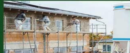
Wenn der alte Putz reißt oder bröckelt, sollte der Hausbesitzer nicht lange mit einer Sanierung warten. Risse und Löcher in der Fassade sind nicht nur unschön, sie können langfristig schwere Schäden zur Folge haben, weil der Außenputz das Mauerwerk nicht mehr ausreichend vor Feuchtigkeit und Umwelteinflüssen schützen kann. Aber keine Sorge, um dabei höhere Kosten zu vermeiden, lohnt es sich einen Experten von uns zu rufen und den Schaden langfristig zu beheben.
